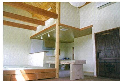
▲同社の施工例。古い蔵の戸を再利用し、天井・床・腰板には杉の無垢材を採用している。
